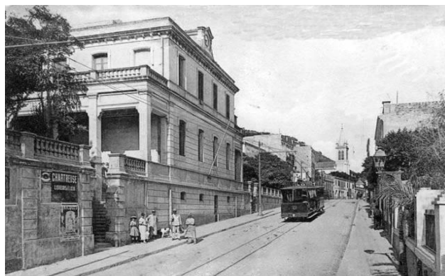
L'avenue Maréchal Foch, le Groupe scolaire et l'Eglise en 1912
